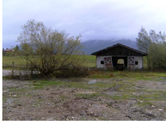
Blick von Süden nach Norden (Schuppen seit Winter 2015/16 ohne Dach)
