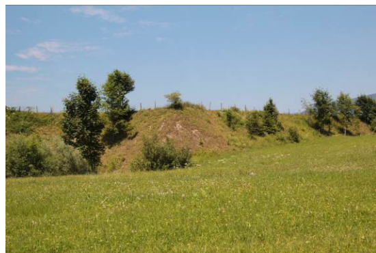
Abb. 10: südostexponierte magere Böschung mit lückigem Gehölzbewuchs
